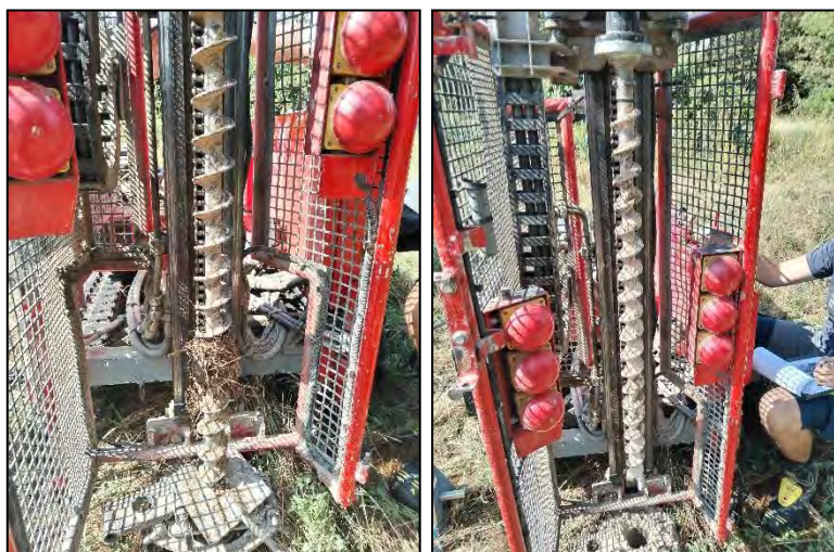
Figure 15 : Photo du sondage ST1, de la gauche vers la droite de la surface vers la profondeur
